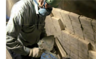
煉瓦積み作業
