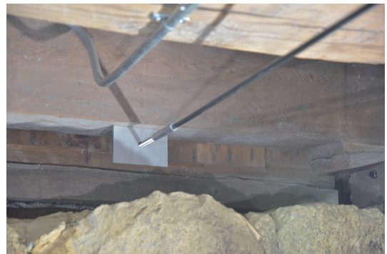
写真 4 同上補強材の接合部（チタン合金ボルト） Reinforced member joint of structure shown on Photo 3 (using titanium alloy bolt)
