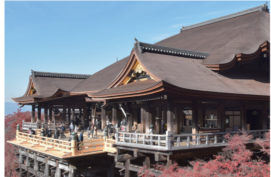
写真 3 床下補強された構造体の外観（清水寺舞台下） External view of reinforced deck supporting structure (Kiyomizu Stage, Kiyomizu-dera Temple)
