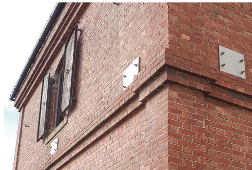
写真8 富岡1号倉庫補強 Reinforcement of Tomioka Warehouse No.1
