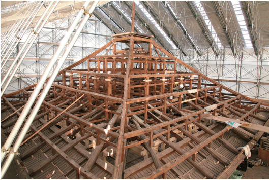
写真 1 信州善光寺経蔵小屋組全景 Panoramic view of roof system of Sutra Repository, Zenkoji Temple
