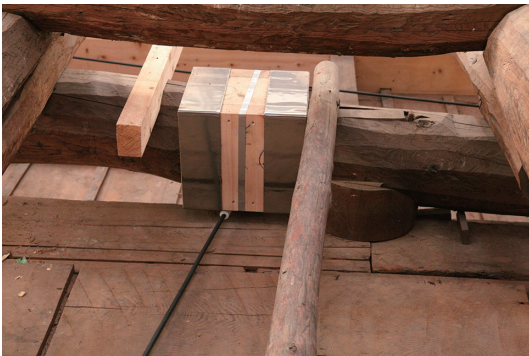
写真 2 同上部材チタン合金シート巻き付け Titanium alloy sheet wrapped member shown on Photo 1
