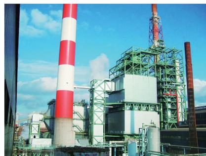
図8 活性コークス式乾式脱硫脱硝設備
