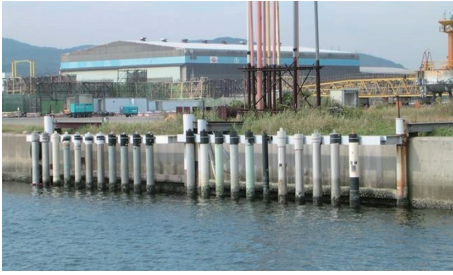
図4 実海域岸壁での暴露試験 Exposure test in coastal area
