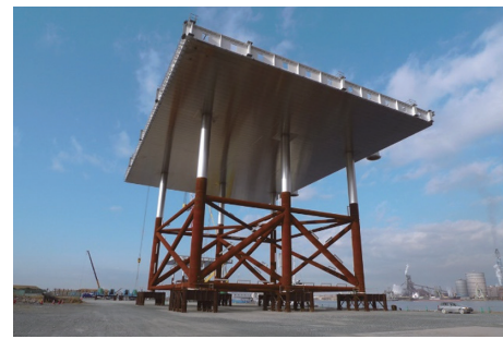
図13 ジャケット構造物 Jacket structure
