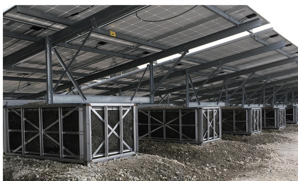
写真6 太陽光パネル架台へのFW鋼の適用例
