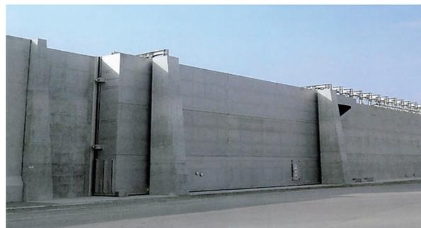
写真7 国内最大の陸間門(岩手県宮古市)の採用例
