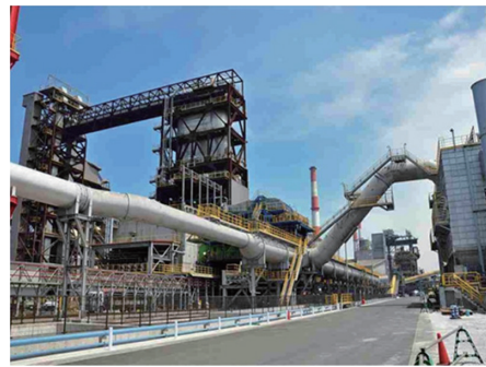
図16 名古屋第5コークス炉の概観 Overview of Nagoya No.5 coke plant
