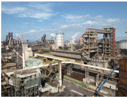
図15 大分第5コークス炉の概観 Overview of Oita No.5 coke plant
