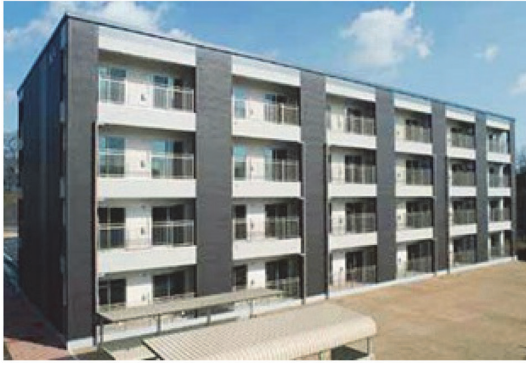
写真 2 4階建てスチールハウス 4-storied steel framed house
