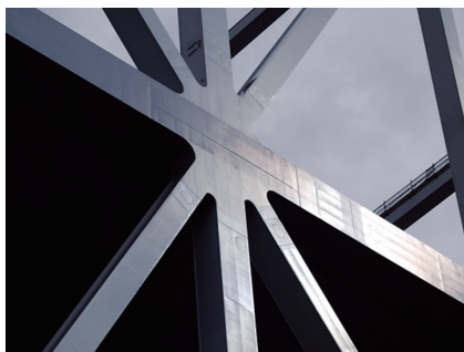
写真 4 東京ゲートブリッジの格点 Example of the panel points on the Tokyo Gate Bridge
