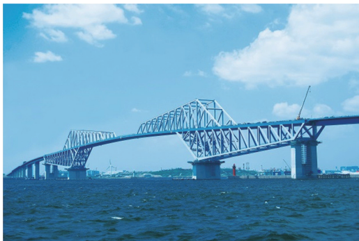
写真 3 東京ゲートブリッジの外観写真 Appearance of the Tokyo Gate Bridge
