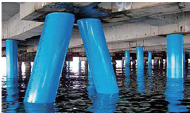
写真1 ペトロラタム被覆工法（FRPカバー）を適用した鋼管杭
