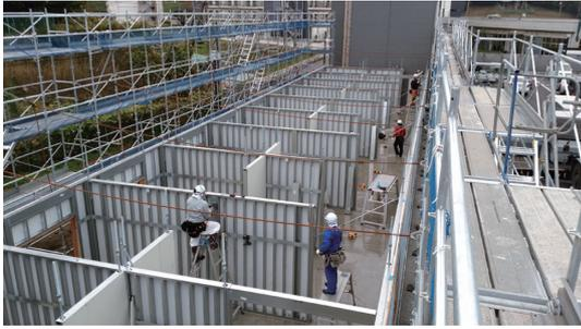
写真8 屋起し専用工具による建入れ直し
