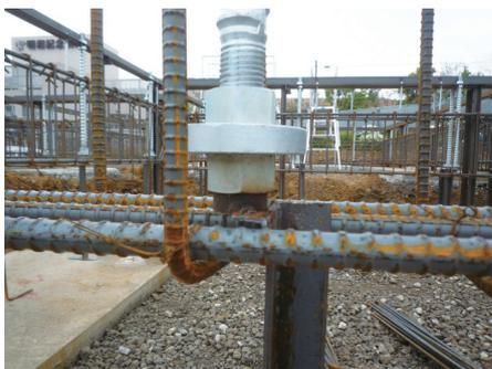
写真12 鞘管による固定
