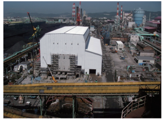
図8 仮設材、シート素材適用の実施例（和歌山製鉄所第1Aコークス炉）
