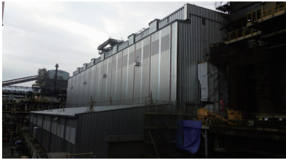
(d) Completion of temporary building
