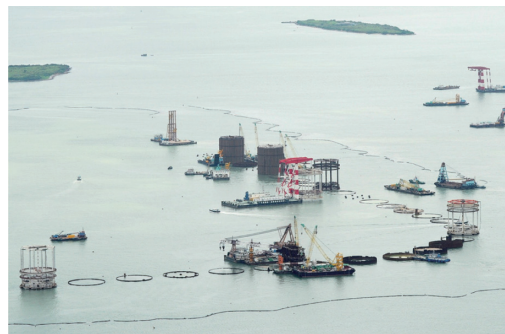
写真10 香港/HKCBFにおける鋼矢板セルの施工 Installation of steel sheet pile cell at HKCBF in Hong Kong
