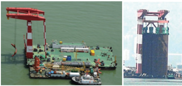
写真8 香港/HKCBFにおける低空頭起重機船 Installation barges for limited height for construction
