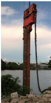
写真3 バイブロハンマー工法による施工 Installation by vibratory hammer
