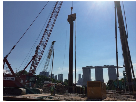
写真6 シンガポール／MRTトムソンライン駅舎工事の施工状況 Installation of Hat+H at MRT Project in Singapore
