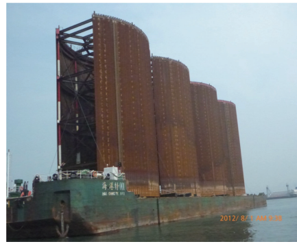
写真9 香港/HKCBF工事における4分割セルの輸送 Delivery the fabricated quarter cells
