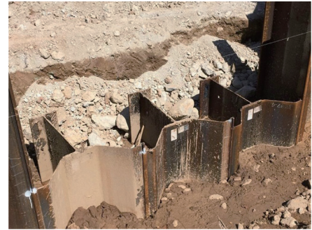
写真7 シンガポール／ハット+H打設後状況 Installed Hat+H at MRT Project in Singapore
