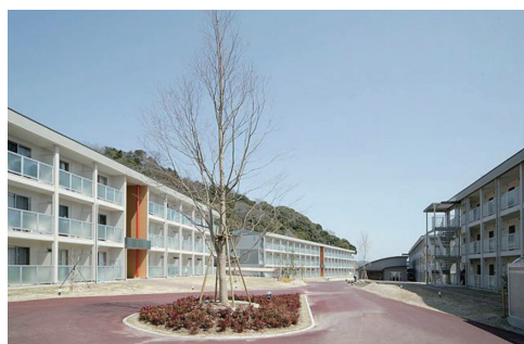
写真6 北九州市留學生宿舎 (3階建て・60分準耐火建築物、2005年3月竣工) 3-story dormitory for foreign students in Kitakyushu City (60-minute quasi-fire-resistant building)
