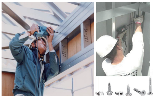
写真3 ドリルねじによるパネル接合 Jointing method for structural panel with self-drill screw
