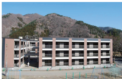
写真7 釜石市中上島復興公営住宅 (3階建て・耐火建築物、2013年3月竣工) 3-story restoration public housing in Kamaishi, Iwate (1-hour fire-resistant building)
