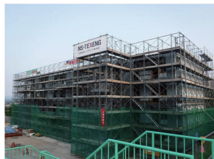
(d) Construction of fourth-story
