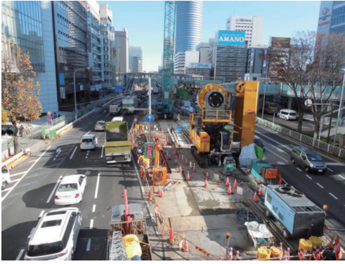
写真 12 施工状況 (新横浜地下駅舎工事) Construction (Shin-Yokohama Underground Railroad Station)
