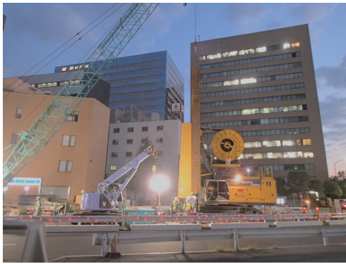
写真9 夜間施工状況 Night construction
