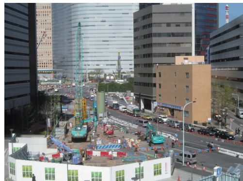
写真8 工事場所の日中の状況 5) Daytime of the construction site
