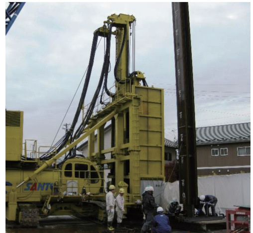
写真10 施工状況（長野北部幹線工事） 6) Construction (Nagano Northern Trunk Line)
