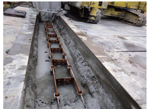
写真11 NS-BOX 建込み後の状況 6) After NS-BOX built
