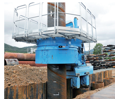
写真1 コンビジャイロ工法の施工性確認試験状況 Construction test of Combi-Gyro Method
