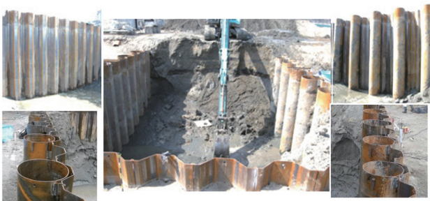
写真 3 実大掘削試験状況 Actual excavation test
