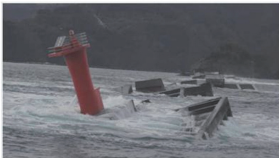
写真1 釜石港湾口防波堤の北堤堤頭部付近の被災状況 1) Damaged breakwaters in Kamaishi Port
