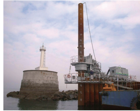
写真5 ジャイロプレス工法による捨石層施工事例 7) Example of construction that Gyropress method surged the layer of rubbles
