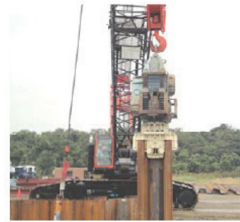
写真5 打設状況(バイブロハンマ工法) Condition of vibratory driving
