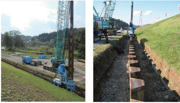
写真 14 堤防対策適用状況 Condition of application for levee
