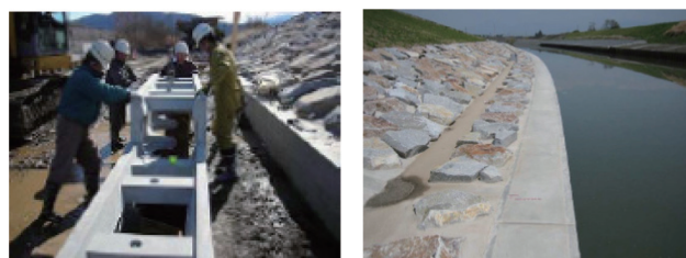
写真8 ハット形鋼矢板プレキャスト型頭部被覆工 3) Precast concrete cooping of hat-type steel sheet pile
