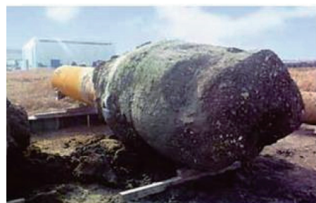
写真2 掘り起こした杭の根固め(鋼管径1000mm) Photo of turned pile (D: 1000mm)
