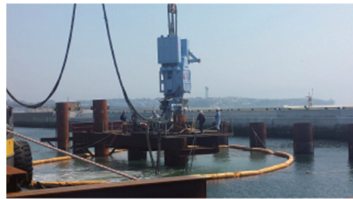
写真7 小名浜港（東港地区）でのRS プラス工法施工状況 Construction of RS plus method on the Onahama Port
