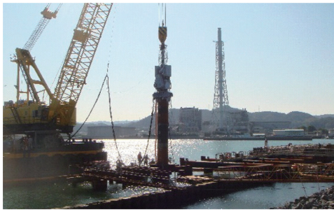
写真5 唐津港でのRS プラス工法施工状況 Construction of RS plus method on the Karatsu Port
