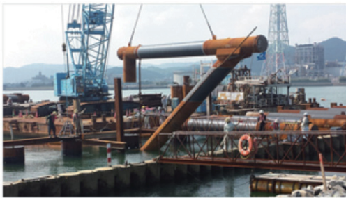
写真6 唐津港での水中ストラット据付状況 Installation of submerged strut members on the Karatsu Port
