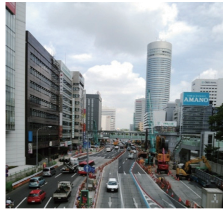
写真6 ソイルセメント鋼製地中連続壁の施工状況 Construction of steel diaphragm wall with soil cement
