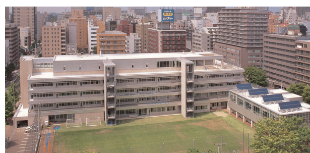
写真10 札幌市資生館小学校 30) Shiseikan Elementary School in Sapporo
