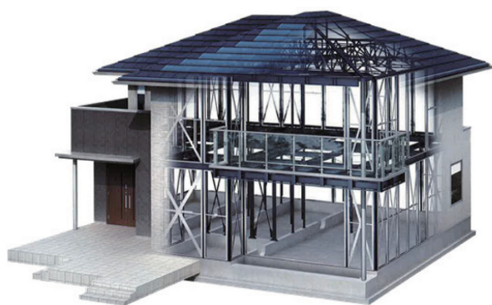
図2 スマートビーム®の採用例 Application of SMart BEAM™
