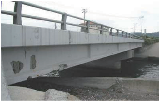
写真2 インフラストラクチャ老朽化 (橋梁の損傷) Decrepit infrastructure (damaged bridge)
