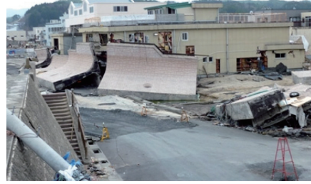
写真3 防波堤, 防潮堤の被災状況 Devastated breakwaters and tide barrier
