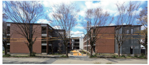
写真 12 上中島復興公営住宅Ⅰ期 (NS スーパーフレーム工法®) 3-story restoration public housing in Kamaishi, Iwate (NS-Super-Frame™)
