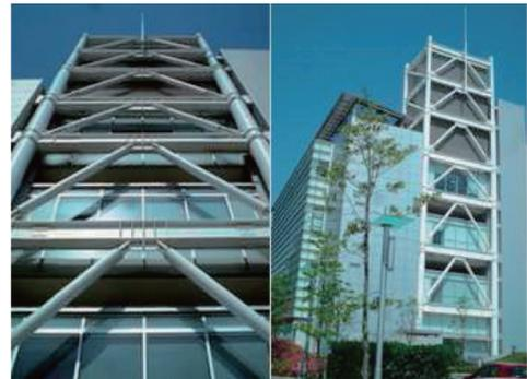
写真5 地震エネルギー吸収ブレース<sup>10,11)</sup>
