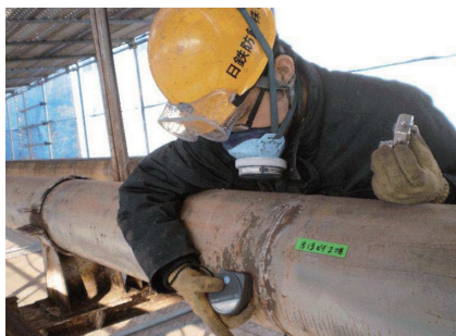
写真12 軽ケレン塗装における残存さび厚みチェック Rust thickness measurement in developed light tool cleaning coating
