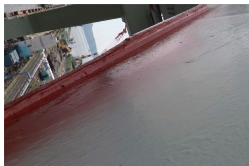
図 21 S2 ローバー・フラット型のアンローダー橋脚部点検撮影写真 (2011年6月27日)
