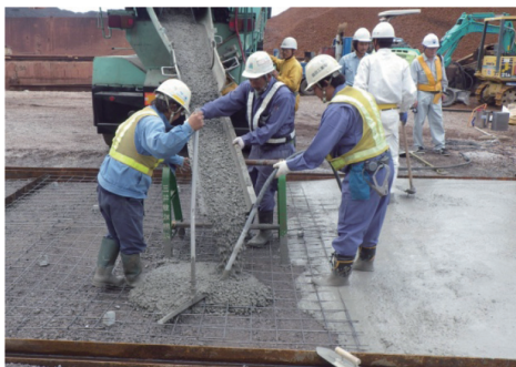
写真 5.1 コンクリートの打ち込み Placing of concrete
