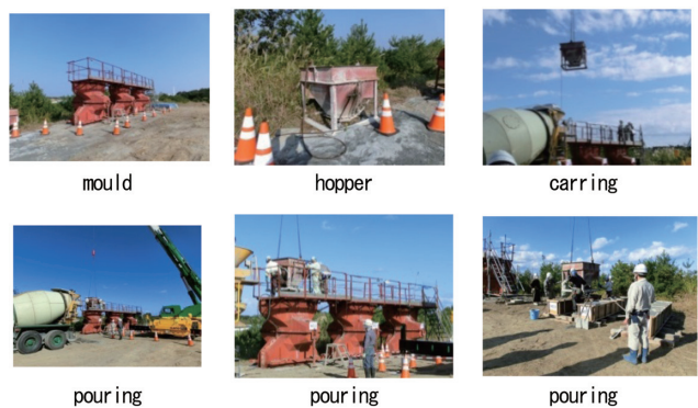
写真 1.4 コンクリート打設状況 Concrete placing situation
