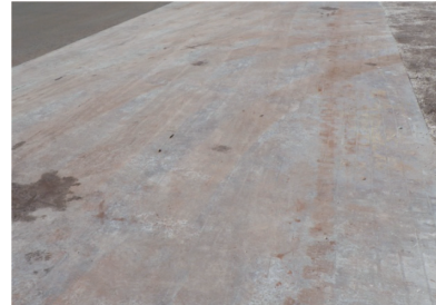
写真 5.2 硬化後の舗装表面 Pavement surface after hardening
