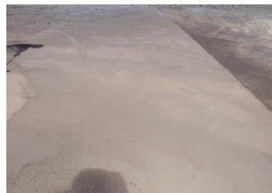
写真 5.3 供用1年後の状況 Pavement surface a year later
