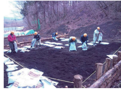
写真8 (b) 施工中 Under construction
