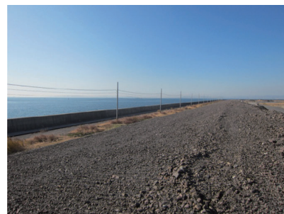
写真 11 (a) 施工前 Before planting
