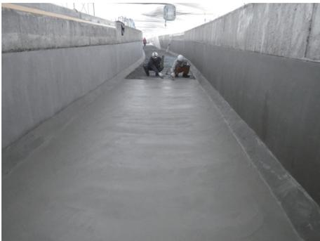
写真4 幹線用水路における断面修復工
