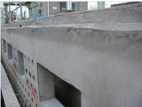
写真5 下水道施設における断面修復工
