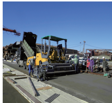
写真1 アスファルトフィニッシャーによる敷均し Roller after spreading the material with an asphalt finisher
