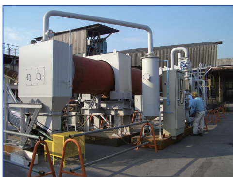
写真2 キルン下流（出側）からの外観 Outlet parts of the kiln
