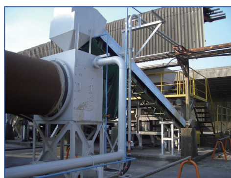
写真3 スラグ投入ホッパー側（入り側）からの外観 Inlet parts of the kiln
