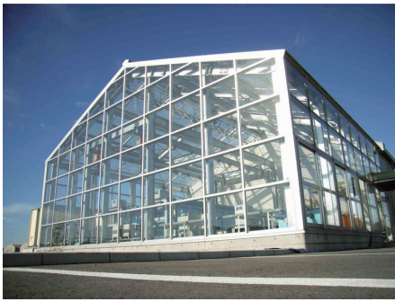
写真1 シーラボ I 外観
