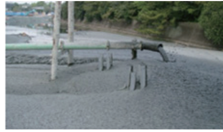
写真3 打設状況 2) Situation of pouring
