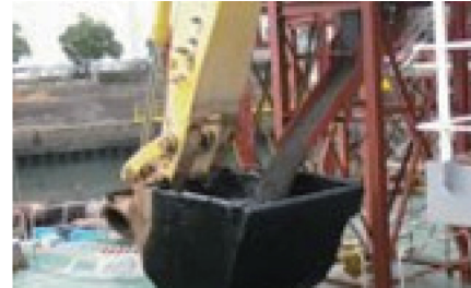
写真4 カルシア改質材計量状況 2) Situation of measuring steelmaking slag
