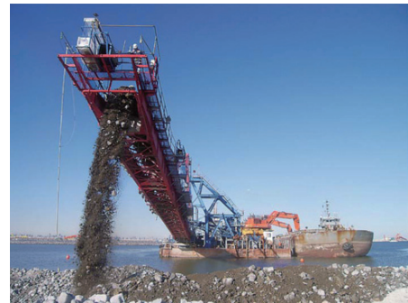
写真 2 フロンティアストーン埋立作業状況 View of reclamation work by “Frontier Stone”
