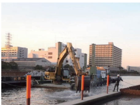
写真4 フロンティアロック投入状況 View of throwing "Flontier Rock"
