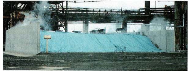
写真1 No. 3 蒸気エージング設備 No. 3 steam aging equipment
