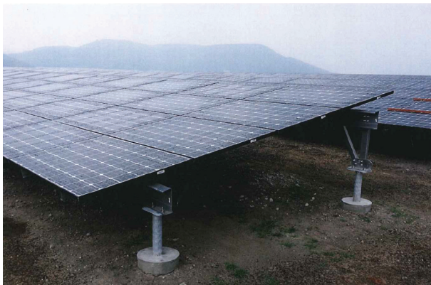
図14 ソーラーパネルでの適用例写真 Example of applications for foundations of the solar systems
