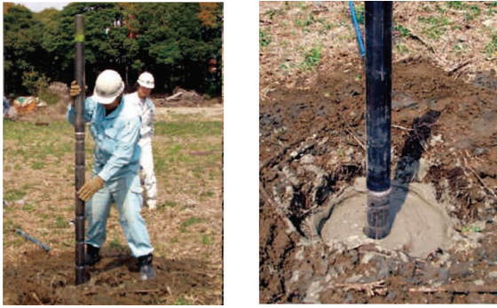
図4 住宅向け地盤改良での適用例
