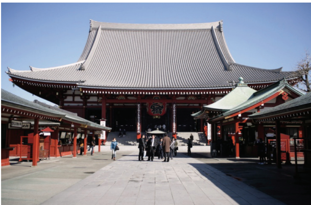
写真6 浅草寺本堂 概観 Titanium roof of Sensouji Temple main hole
