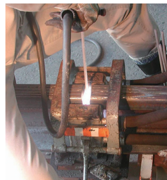
写真7 エンクローズアーク溶接の連続溶接工程の例 Example of continuous welding process in the enclosed-arc welding
