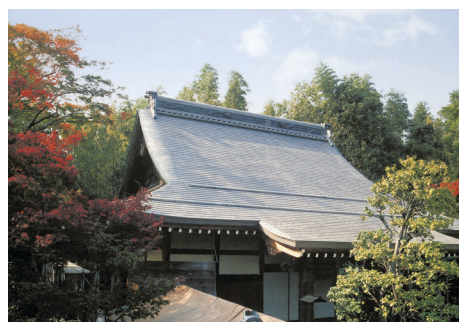
図1 チタン製屋根を葺いた光悦寺本堂
