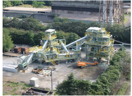
図8 使用済み耐火物のリサイクル設備(大分製鉄所)
