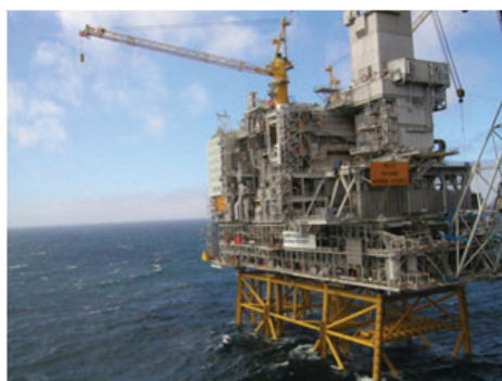
図5 海洋構造物用鋼を用いた固定型生産プラットフォームの上部構造
