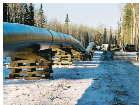
図3 X120ラインパイプの敷設写真
