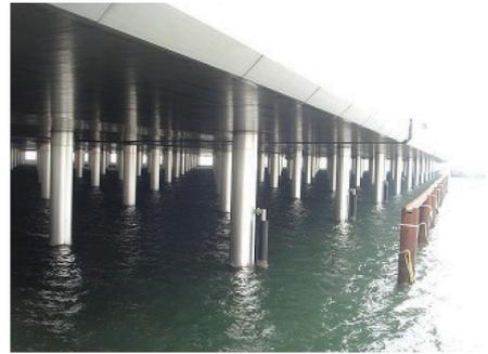
図10 ステンレス鋼被覆（羽田空港D滑走路）
