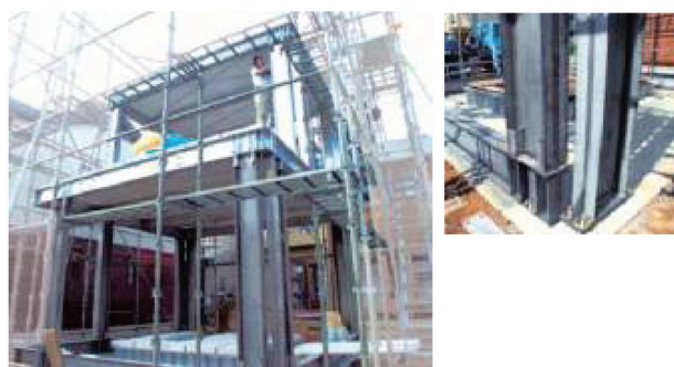
図4 建築構造物クロム系ステンレス鋼YUS410W-MSの適用例（長寿命住宅の1階構造躯体に使用）
