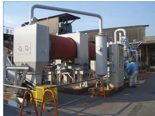
写真7 製鉄所での実機規模試験設備例 Example of full-scale carbonation equipment in the works
