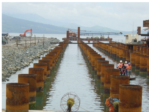
写真3 フィリピン国スービック港棧橋工事での鋼管杭打設状況 Driving steel pipe pile on construction of Subic Bay Port Development in Philippines
