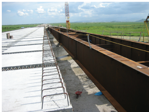
写真1 フィリピン国スービックターラルック高速道路で2主桁橋の架設状況
