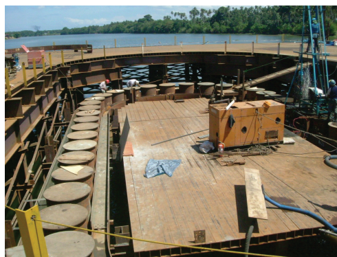
写真4 フィリピン国ミンダナオ島第2マグサイサイ橋での鋼管矢板基礎施工状況
