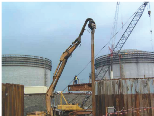
写真 8 台湾での鋼矢板セルの 1 枚打ちの状況(その 1) One by One construction method using straight steel sheet pile in Taiwan (1)
