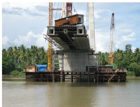
写真5 第2マグサイサイ橋での鋼橋の架設状況 Steel Box Girder construction of Second Magsaysay Bridge
