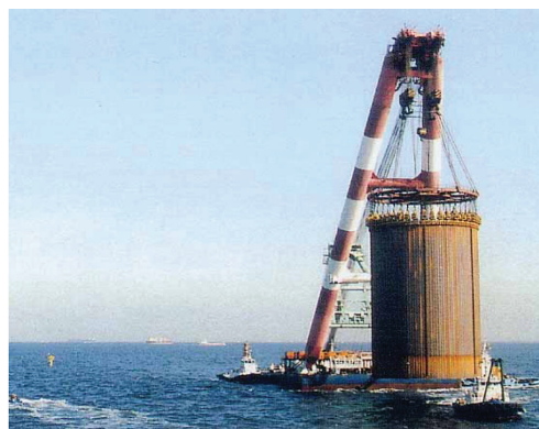
写真7 プレハブ鋼矢板セル工法によるセル運搬状況 Transportation of Cell in Prefabricated Steel Sheet Pile cell structure method
