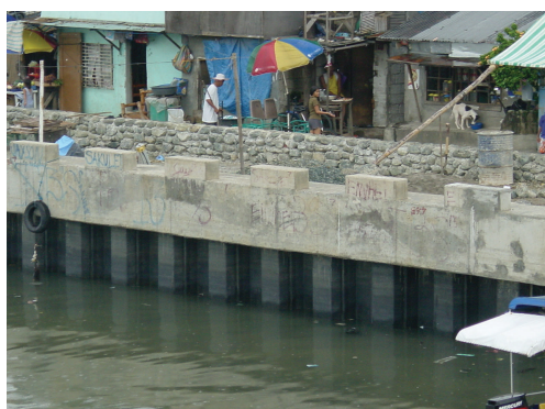
写真2 フィリピン国マニラ首都圏カマナビ地区での鋼矢板護岸(600幅鋼矢板)
