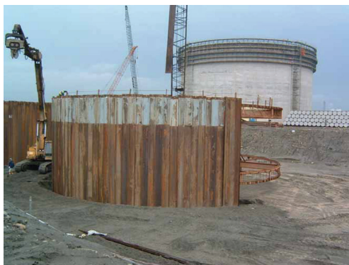
写真 9 台湾での鋼矢板セルの 1 枚打ちの状況(その 2) One by One construction method using straight steel sheet pile in Taiwan (2)
