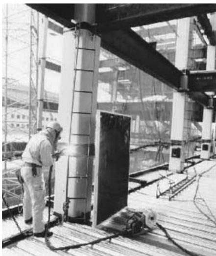
写真6 現場溶接工法 Field welding
