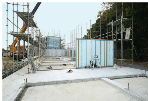
写真6 工場生産比率を高めた外壁パネル
