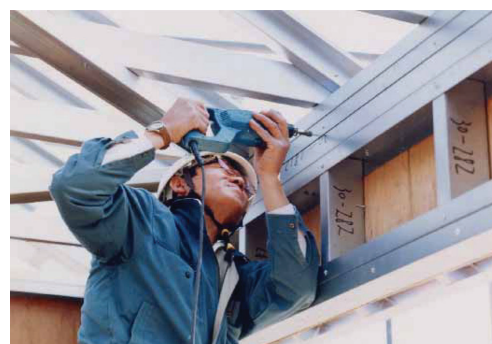
写真2 ドリリングタッピンねじ打設状況 Scene of joining with drilling tapping screws
