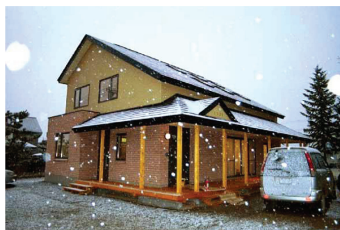
写真5 北海道遠軽町に建設されたスチールハウス Steel framed house constructed in Engaru city, Hokkaido
