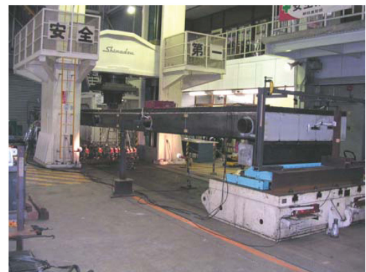
図3 実大載荷試験の状況 Loading test condition
