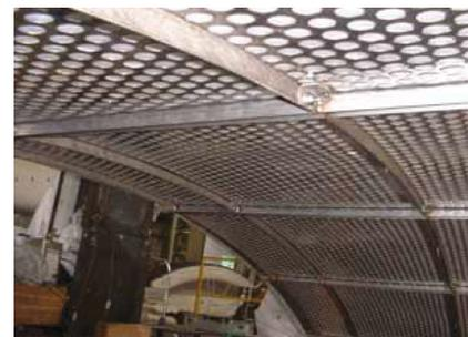
写真3 ブランケット系耐火工の例
