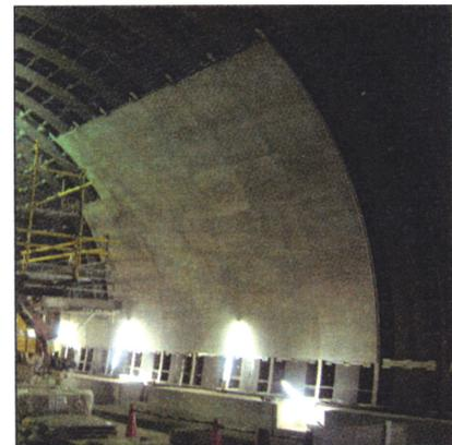
写真2 ボード系耐火工の例
