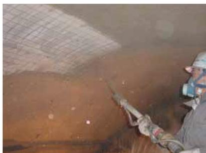
写真1 吹付け系耐火工の例
