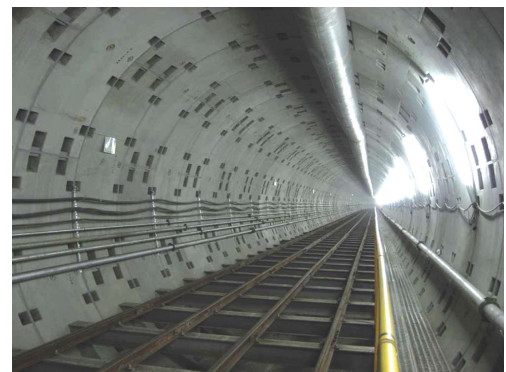
写真4 中央(一)増補幹線(第2工区)坑内写真 Shield tunnel constructed with CP segments
