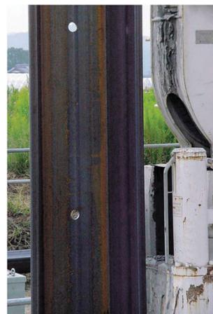
写真1 透水性鋼矢板
