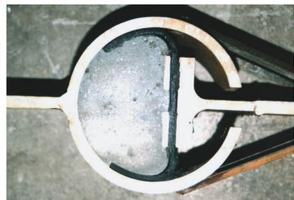
写真6 漏洩防止ゴム板付き継手
