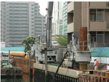
写真8 ジャイロプレス工法施工状況2
