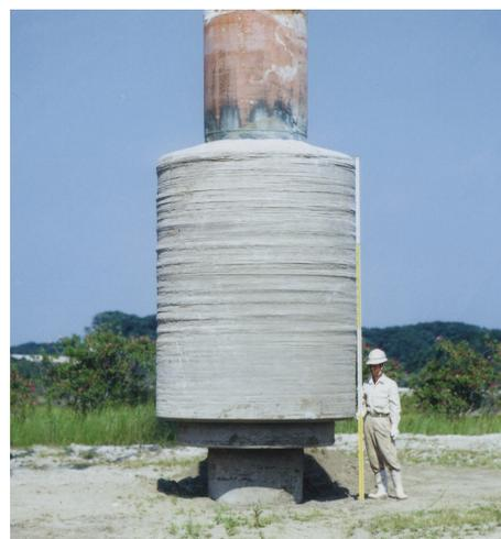
写真2 拡大根固め部
