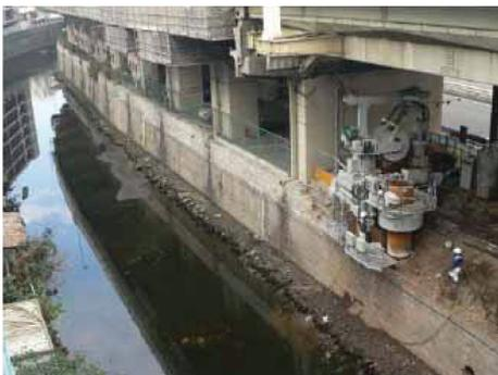
写真7 ジャイロプレス工法施工状況1
