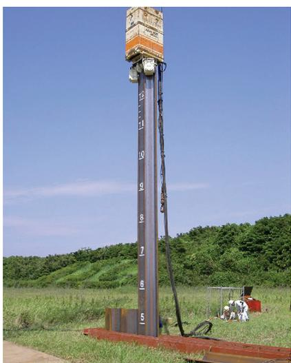
写真2 バイブロハンマ工法によるハット形鋼矢板900の施工状況
