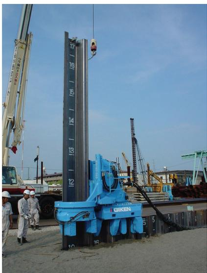
写真3 油圧圧入工法によるハット形鋼矢板900の施工状況
