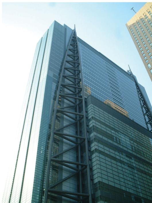
写真1 アンボンドプレースを用いた日本テレビタワー
